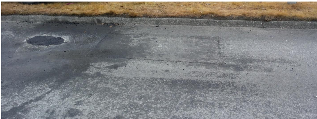
Mynd 19 Viðgerð á malbiki eftir sögun (til hægri) og kjarnatöku (til vinstri)
