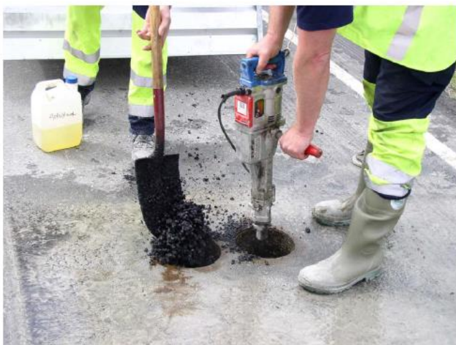
Mynd 18 Holur fylltar með viðgerðarmalbiki og þjappað með hamri í nokkrum lögum
