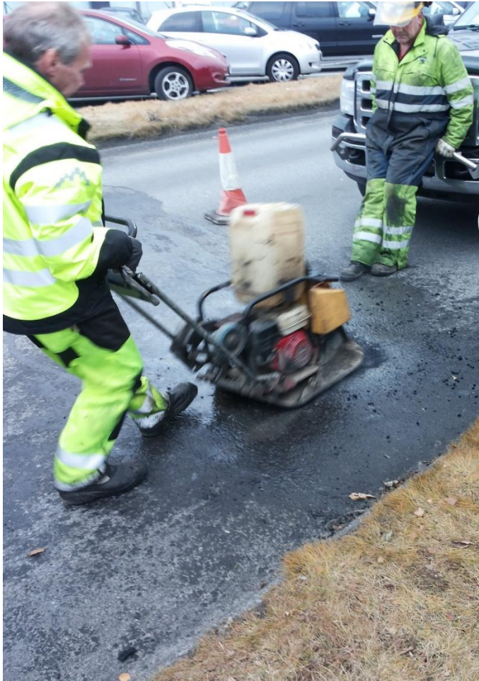
Mynd 17 Malbik þjappað í kjarnaholurnar með jarðvegsþjöppu
